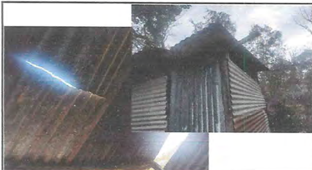
Foto 9: Parte del techo de la cocina está dañado y el corredor se ha caído.
