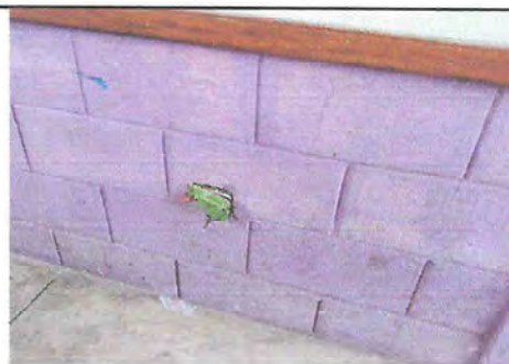
Foto 12: La mayoría de elementos del sistema eléctrico necesita ser renovado (cableado, tomacorrientes, contador)
