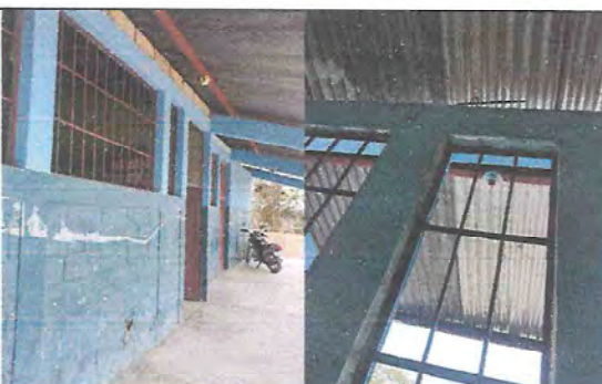
Foto 10: La parte superior de las aulas necesita ser sellada correctamente con block y cemento, se necesitan plafoneras.
