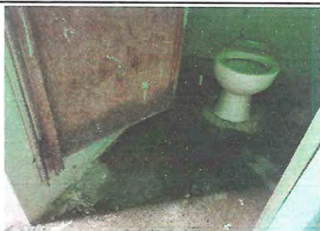
Foto 11: Los baños necesitan ser cambiados los inodoros, repintar, cambiar puertas y sistemas de agua y hay sectores del centro educativo donde se necesita cambiar la torta del suelo.
