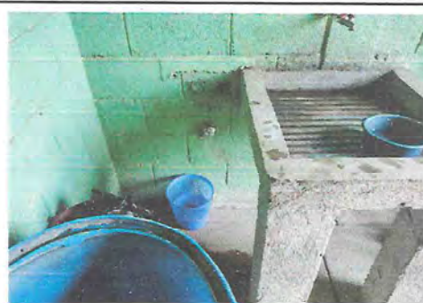
Foto 2: Solo existe un lavadero con un tonel al lado que funciona como lavamanos y pila, por lo tanto necesita ser cambiado por lavamanos y pila adecuados para su uso.
